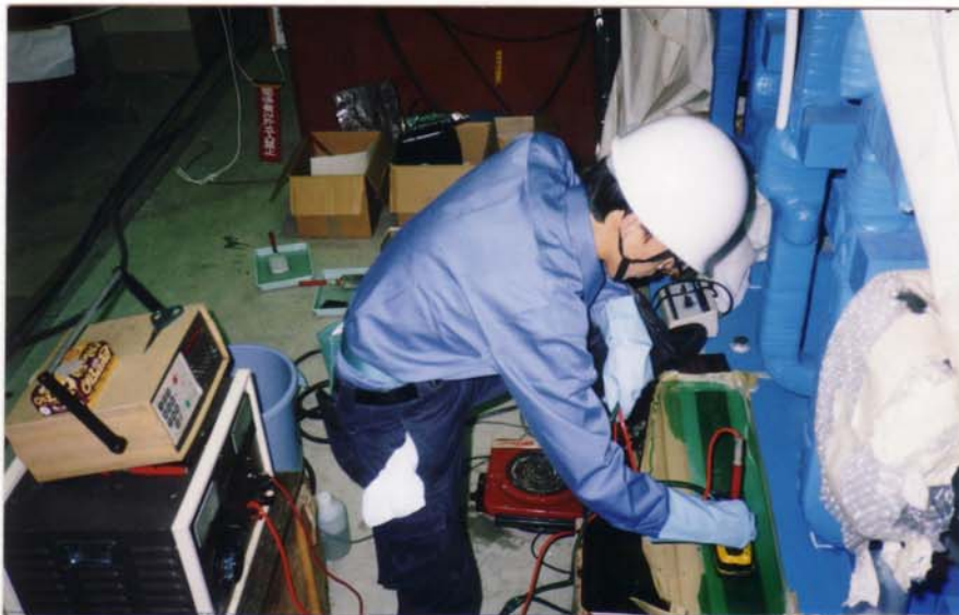
発電所のトランスのブスバー接点部を銀めっき補修した例
