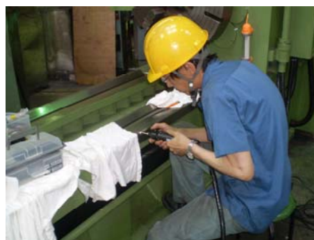
旋盤ベッド部補修
